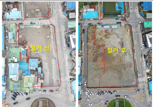
조양문 주변 정비 대상지 매입 및 철거 완료
